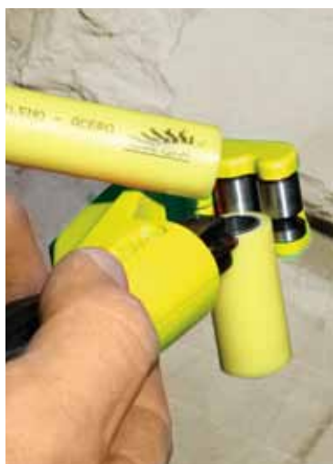
Corte con corta-tubo en obra.
