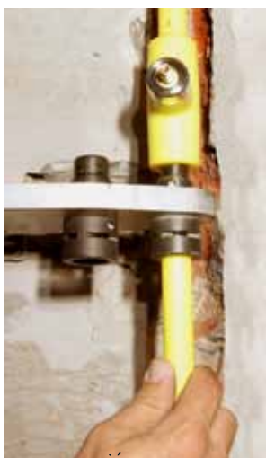
Thermofusion en la canaleta.
